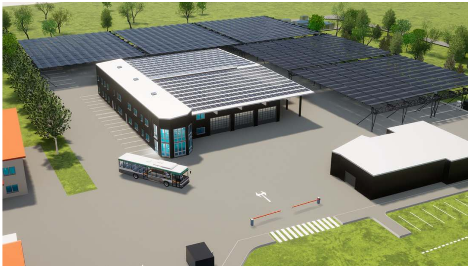
Abbildung 18: 3D-Modell des Betriebshofs mit Photovoltaikanlagen
